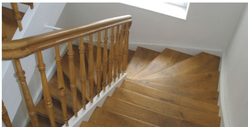
... Nur mit Wandhandlauf ist diese Treppe sicher begehbar
