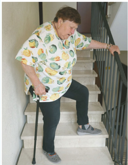
... Das darf nicht sein: Fehlender Handlauf in Wohnanlage
